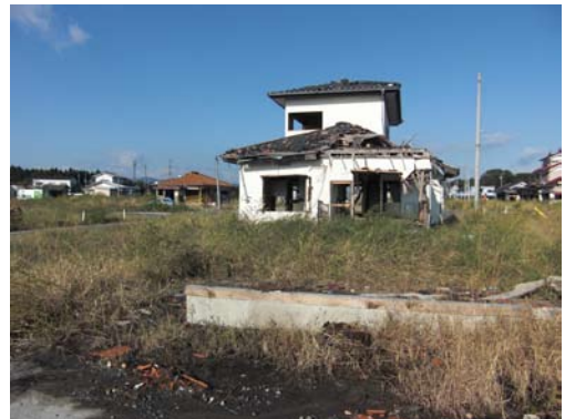
津波の被害をうけた住宅（南相馬市）
